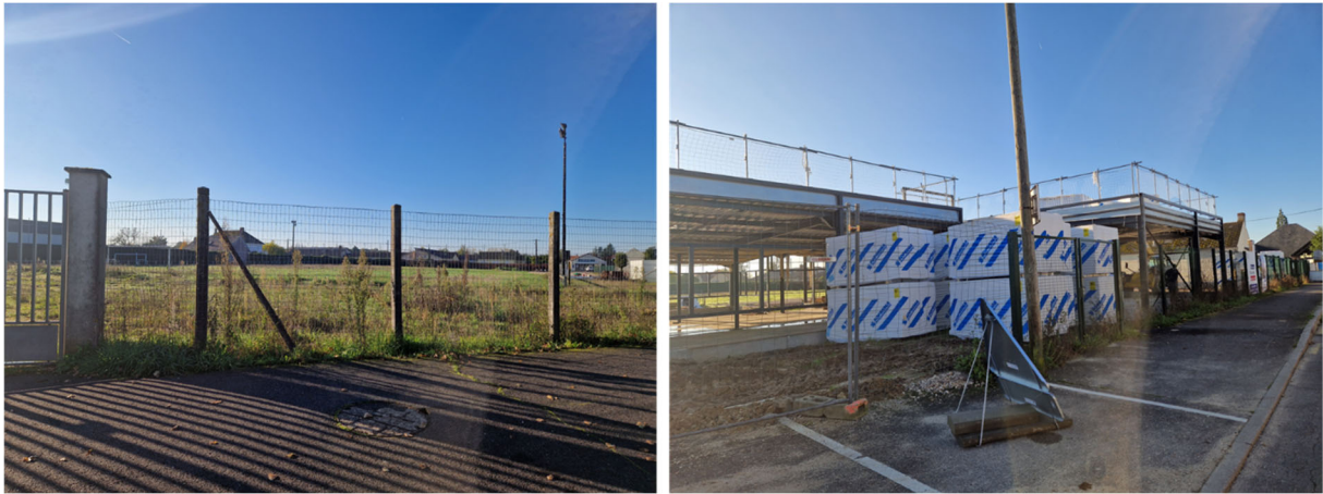
Figure 90 - Ancien terrain de football // construction en cours de la future maison de santé (Terr&Am, octobre 2024)
