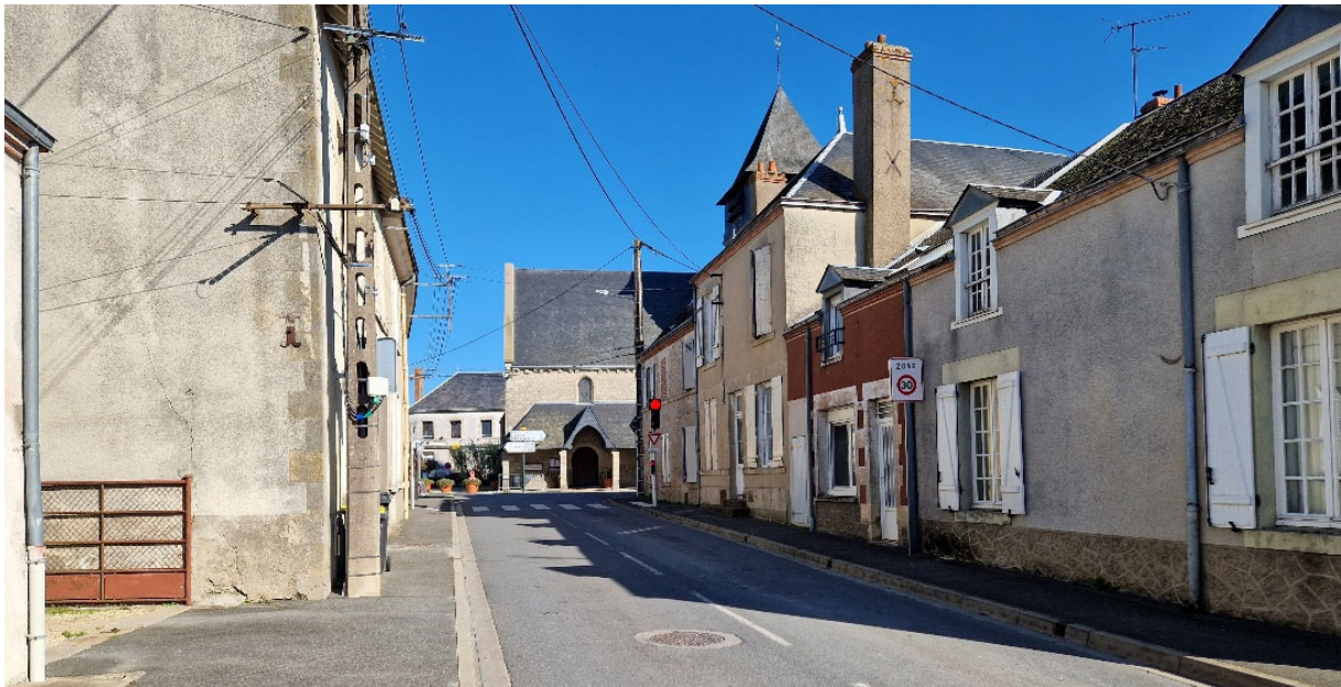
Figure 81 - Rue des Trois Croix, avec un bâti continu et à l'alignement (Terr&Am, octobre 2024)
