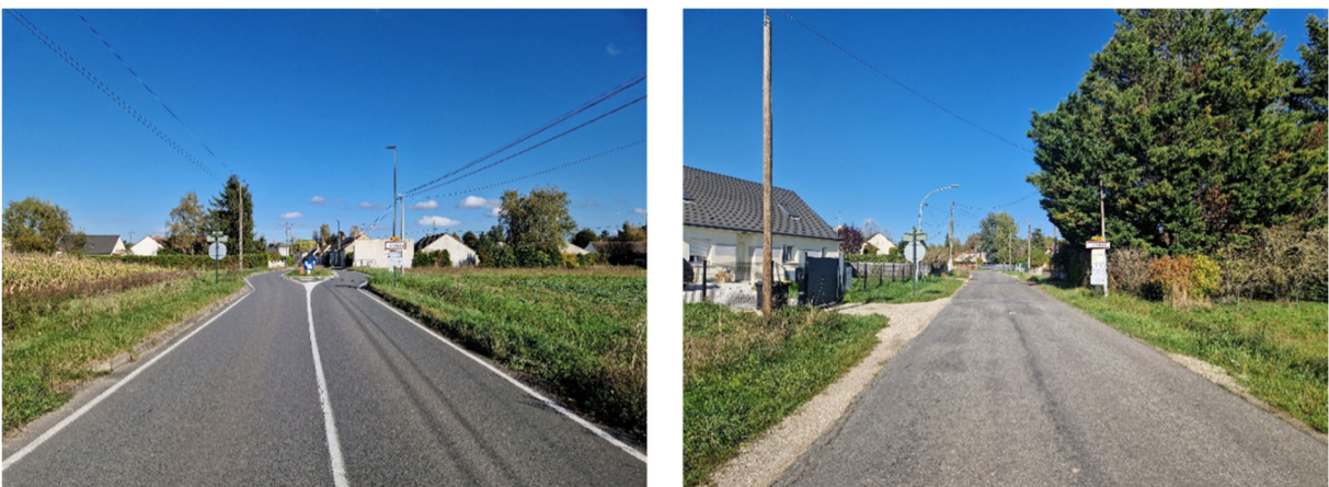
Figure 80 - Entrées Sud (route d'Orléans / route de Donnery) (Terr&Am, octobre 2024)
