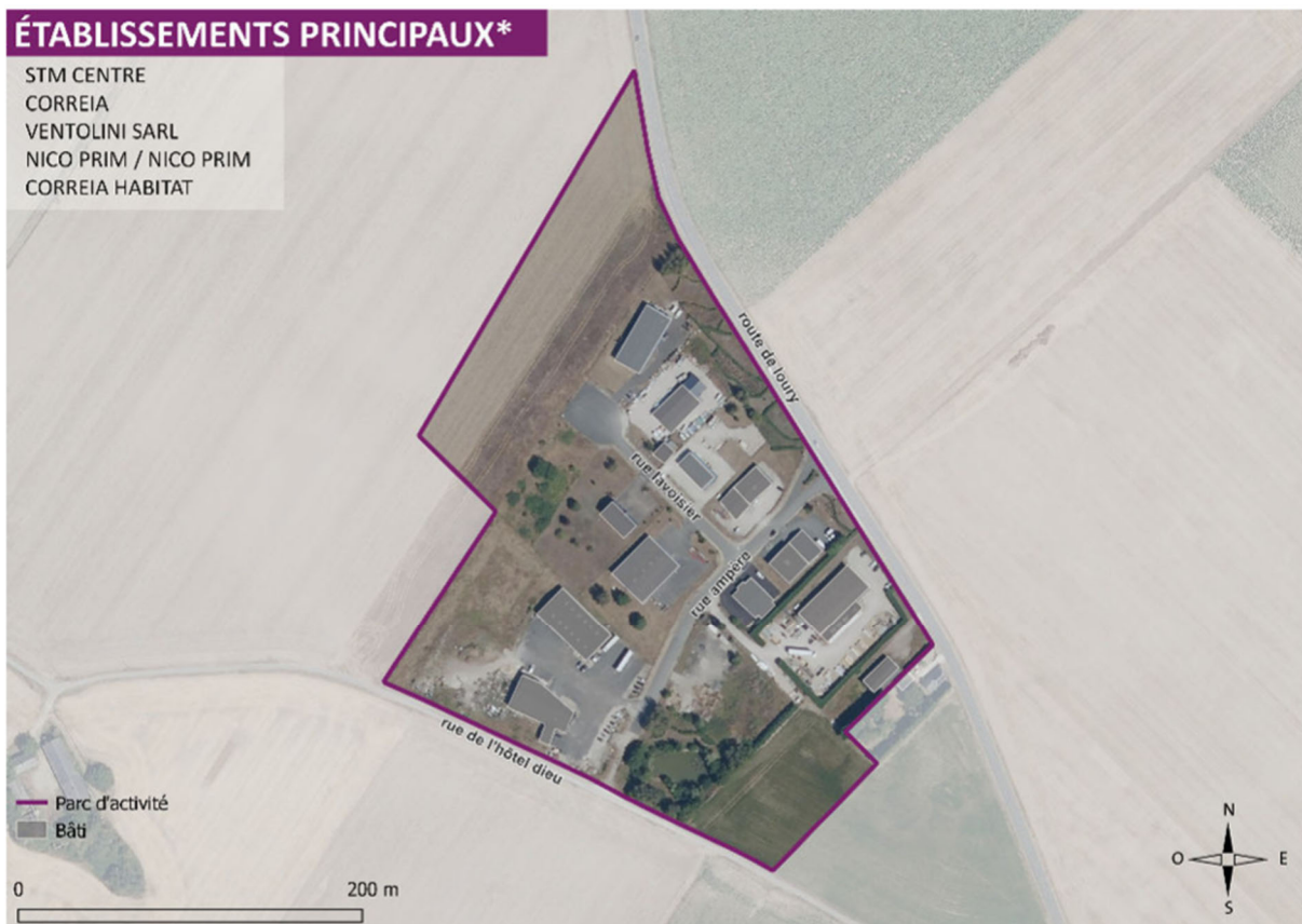
Figure 37 - Vue aérienne de la zone d'activité à Traînou (TOPOS)
