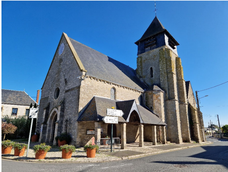
Figure 97 - Eglise Saint-Pierre (Terr&Am, octobre 2024)
