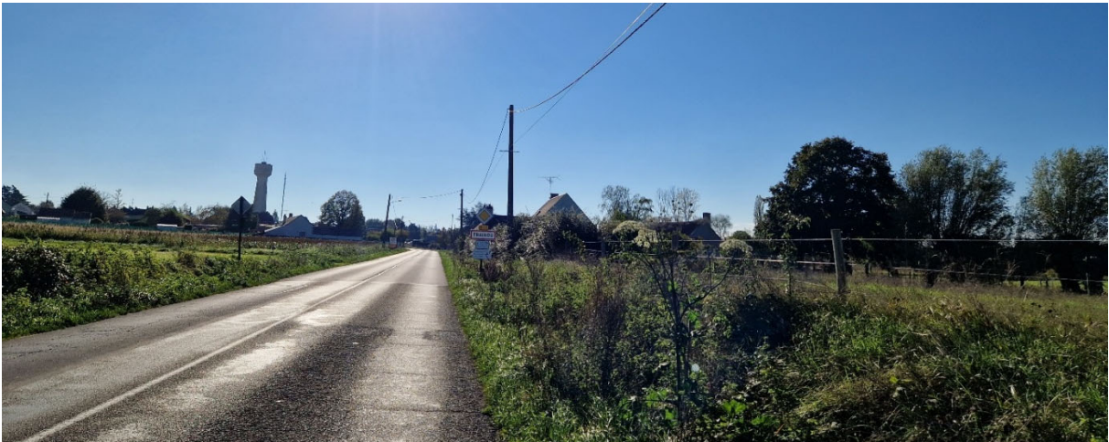
Figure 77 - Entrée Nord-Ouest du bourg - route de Loury (Terr&Am, octobre 2024)
