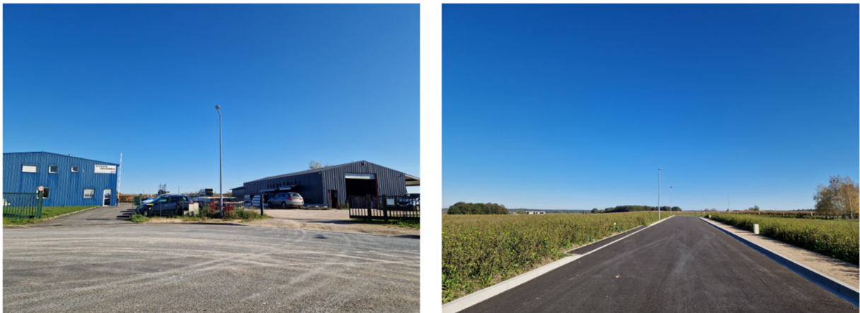
Figure 86 - Vue sur la zone d'activité // l'extension récente de la ZAE (Terr&Am, octobre 2024)
