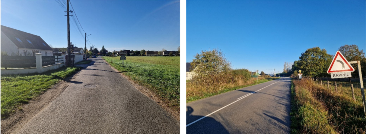
Figure 78 - Entrée Nord (rue de la Motte Moreau) et entrée Sud-Est (route de Fay-aux-Loges) (Terr&Am, octobre 2024)
